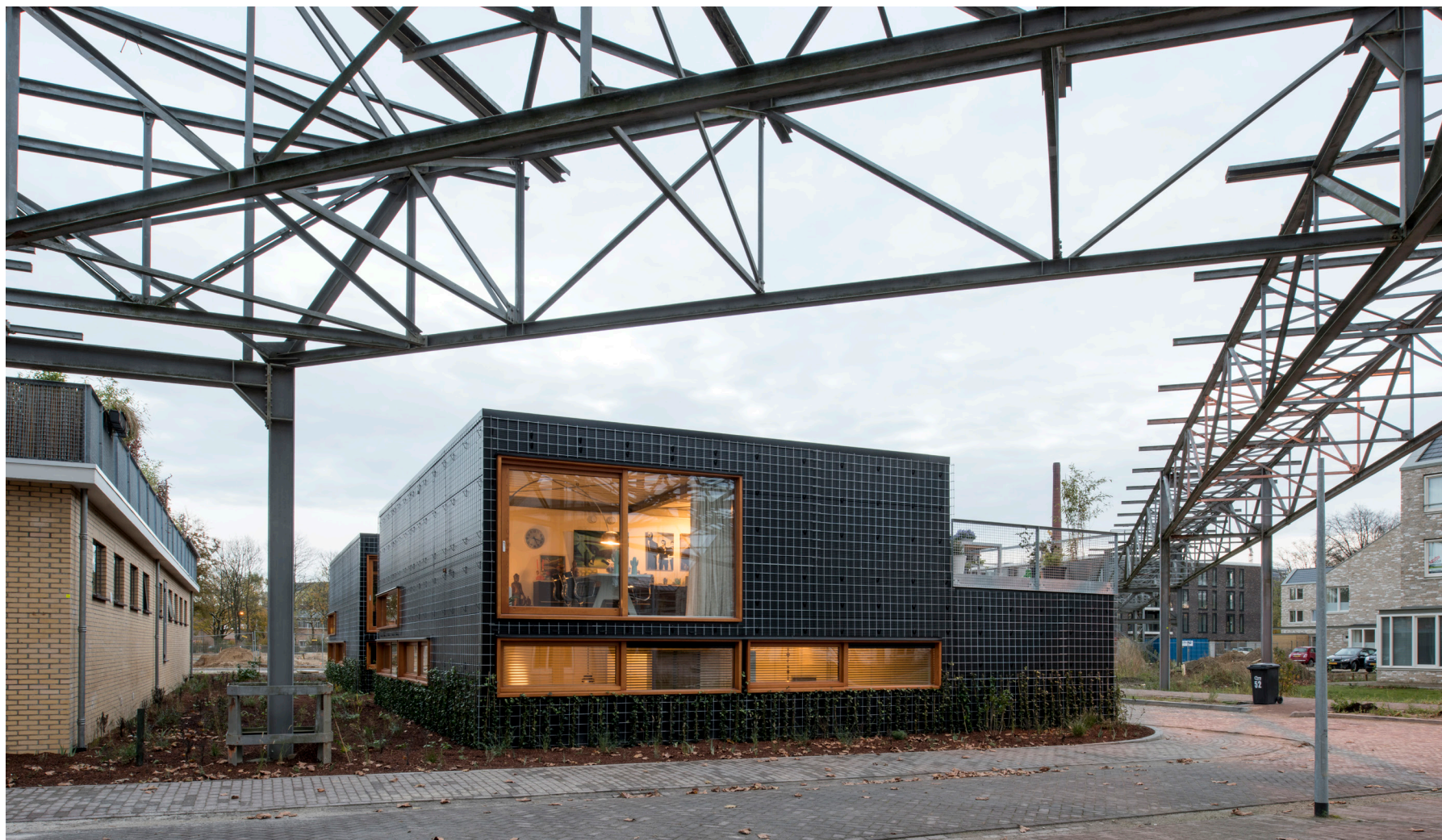
Groene woningen met aan de linkerzijde de balkons van het RAG gebouw
