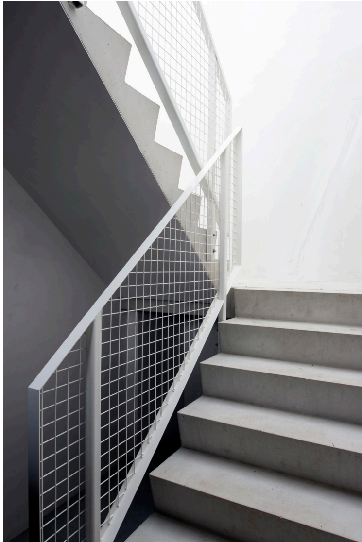
Trap richting eerste verdieping met daklicht
